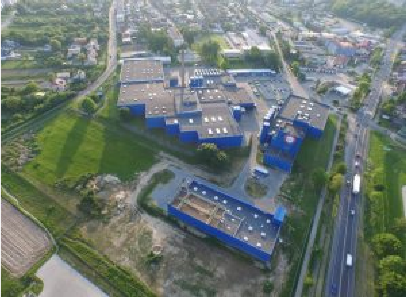
Oczyszczalnia w Rykach
