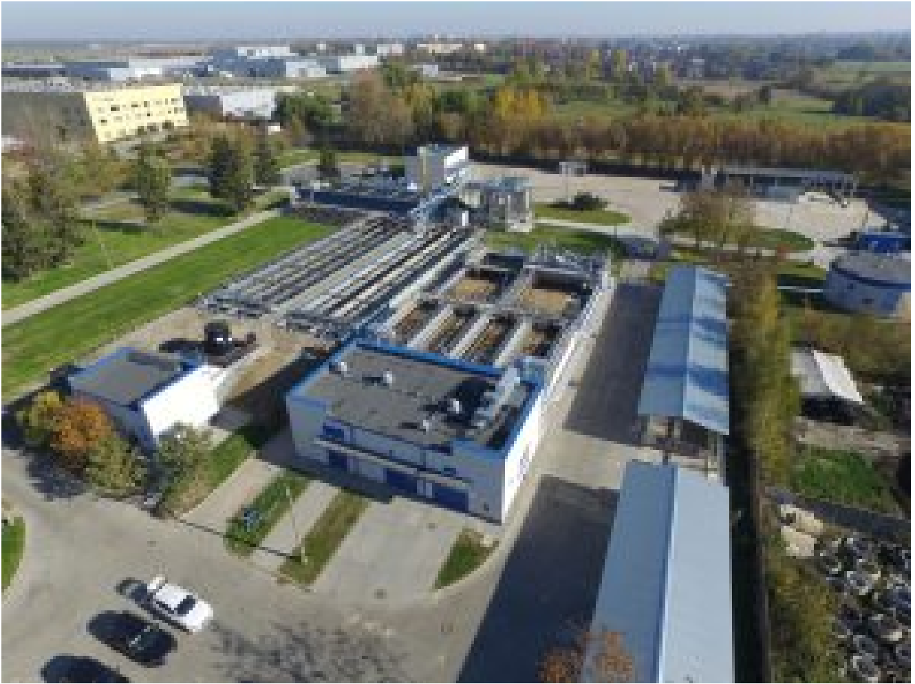
Oczyszczalnia w Garwolinie
