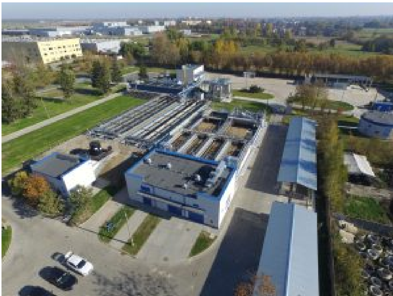
Oczyszczalnia w Garwolinie
