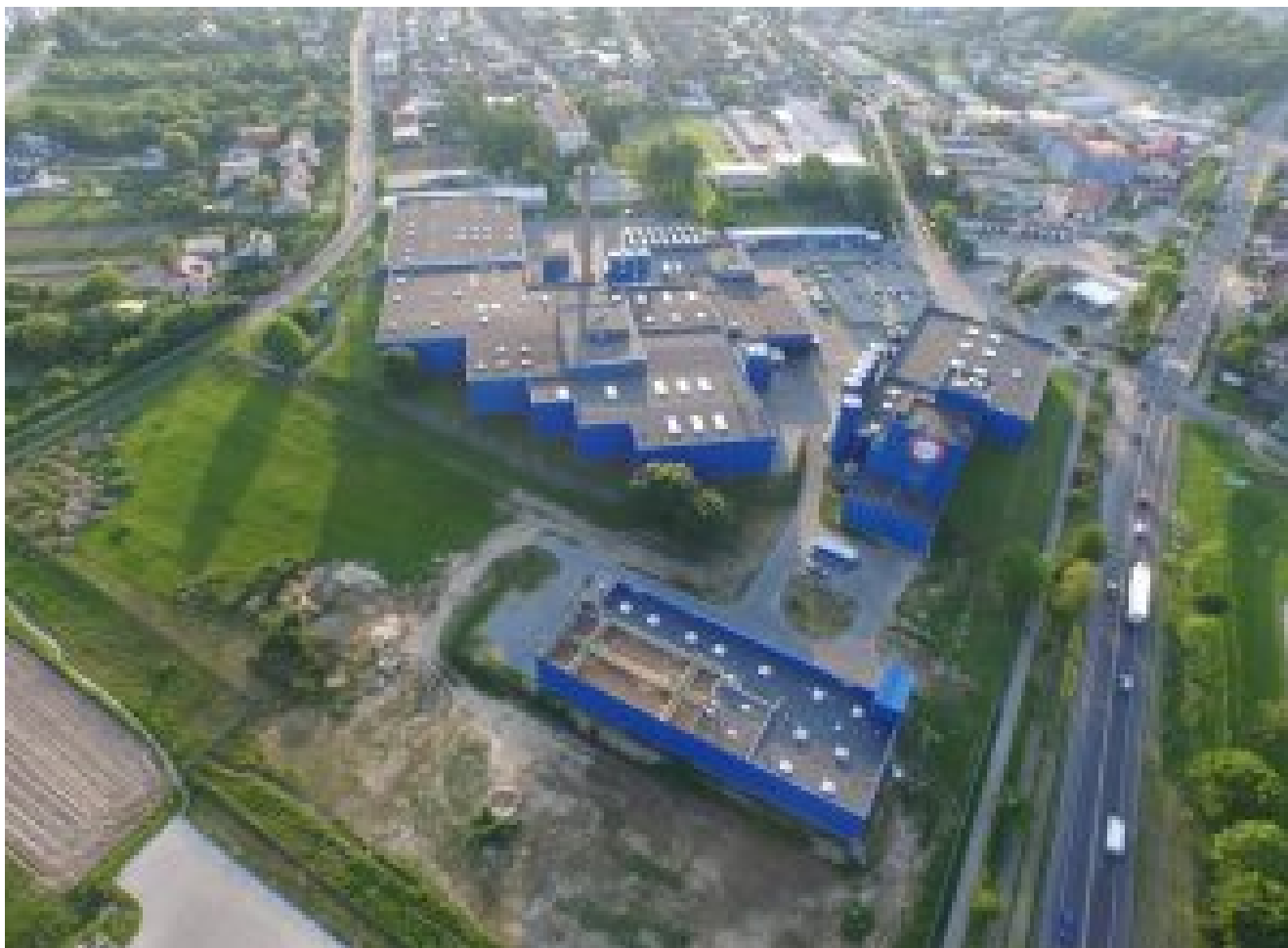
Oczyszczalnia w Rykach
