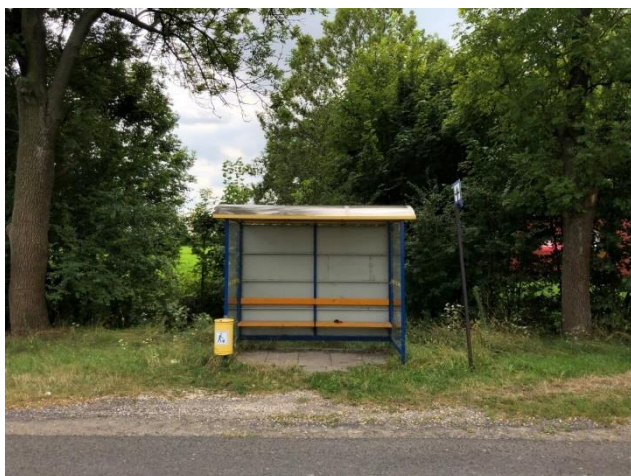
Zdjęcie 7. Nieczynny przystanek autobusowy w Gawartowej Woli
