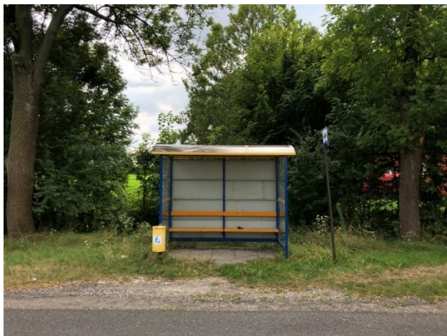
Zdjęcie 7. Nieczynny przystanek autobusowy w Gawartowej Woli
